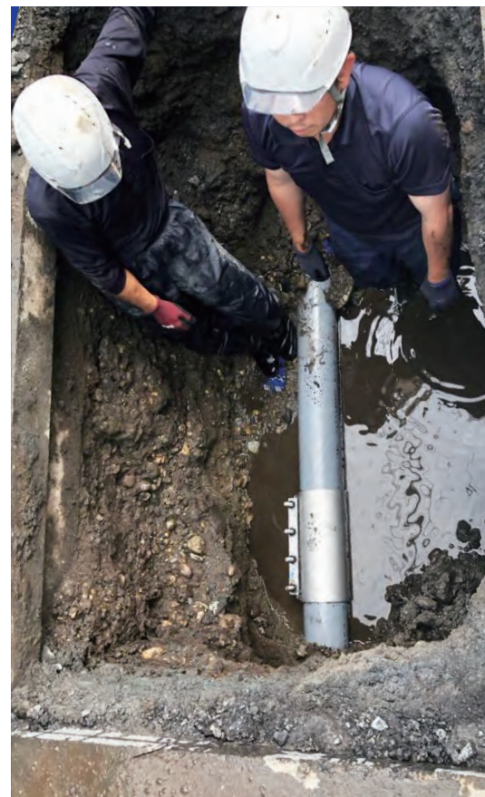
水道管を修繕する様子
