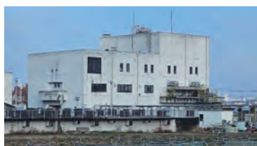
下館水処理センター
