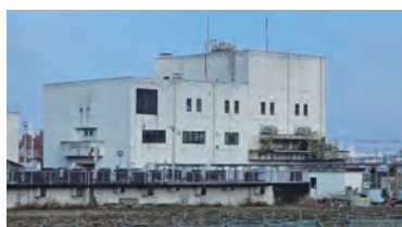
下館水処理センター
