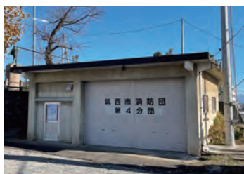
羽黒神社参道入り口にある旧筑西市消防団第4分団詰所
