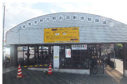
新治駅自転車等駐輪場
