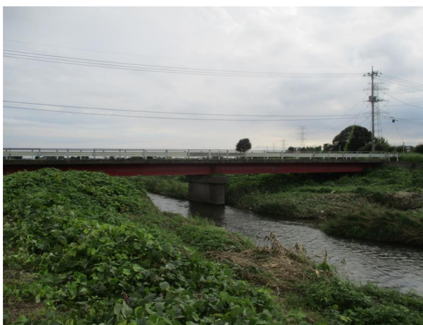
大谷川・筑瀬橋（下館地区）
