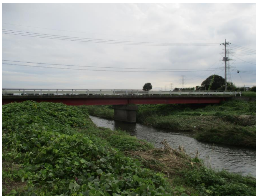
大谷川・筑瀬橋（下館地区）
