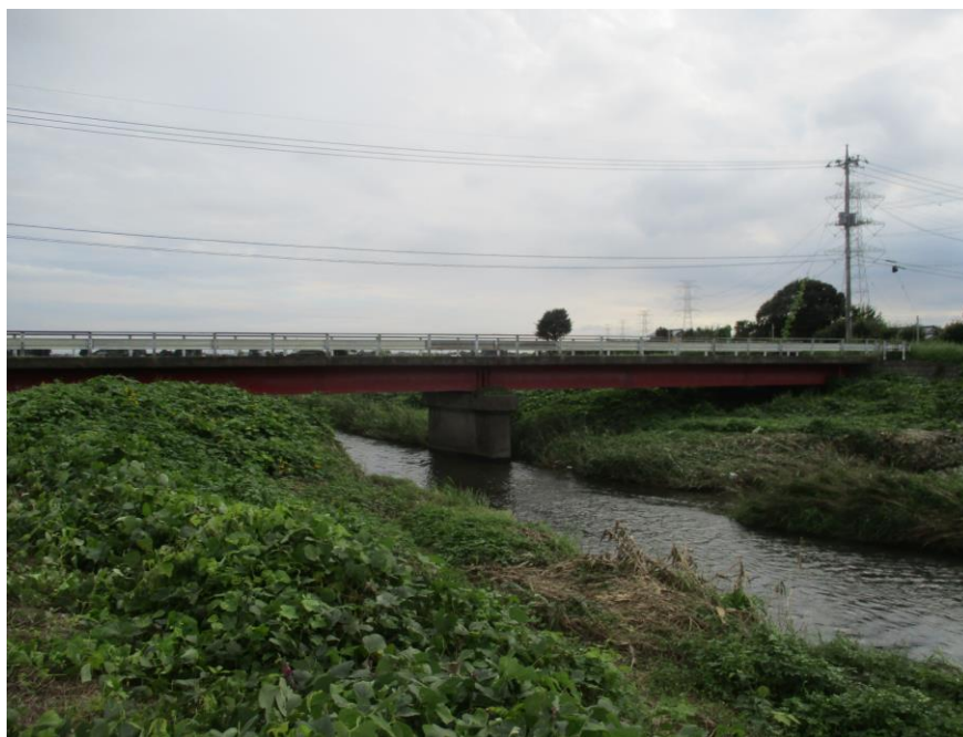
大谷川・筑瀬橋（下館地区）
