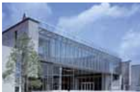
空調トラブルが続く 地域交流センターアルテリオ 早急な対応を！
