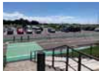
高さも予算も低い「道の駅しもつけ」の拡張駐車場
