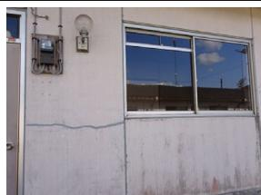
外壁のひびわれ (補修)
