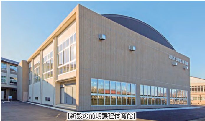
【児童生徒数（開校時）】 926人（予定） 【構造】 校舎・体育館 鉄筋コンクリート造（一部鉄骨造、木造） 【延床面積】 17,890㎡
