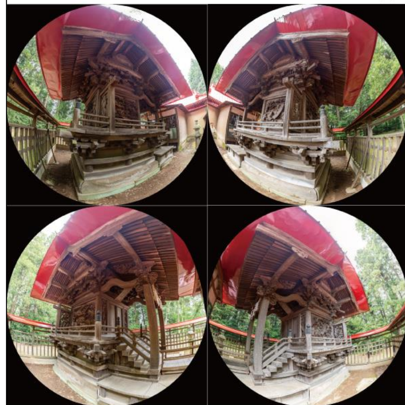
本殿南西角 (本殿_04.jpg)
