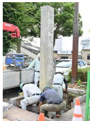
昨年8月に行われた再建工事の様子
