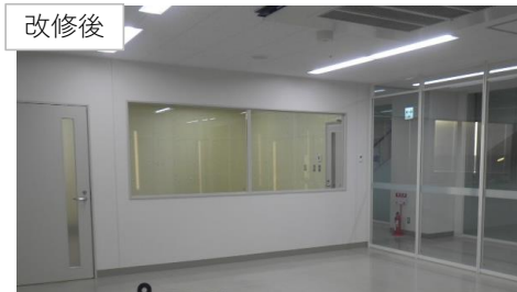
防災システム機器室
