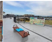
道の駅へのサイン看板、ベンチの設置
