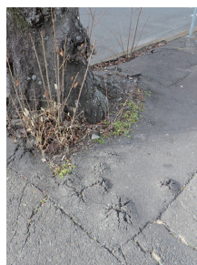
下館駅南の歩道
