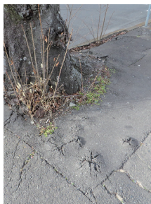
下館駅南の歩道
