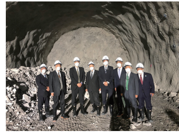
(仮称)上曾トンネル内にて
