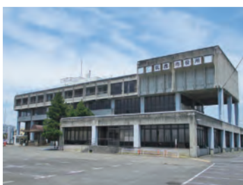
解体予定の下館庁舎
