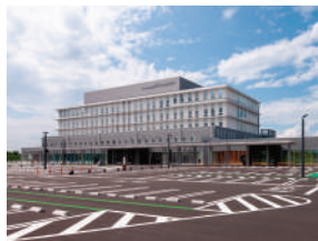
茨城県西部メディカルセンター
