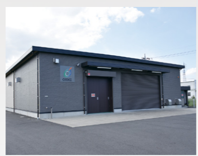
令和元年10月、筑西市小川に新設した「筑西工場」
