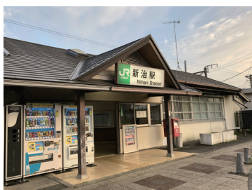
建て替え前の新治駅舎
