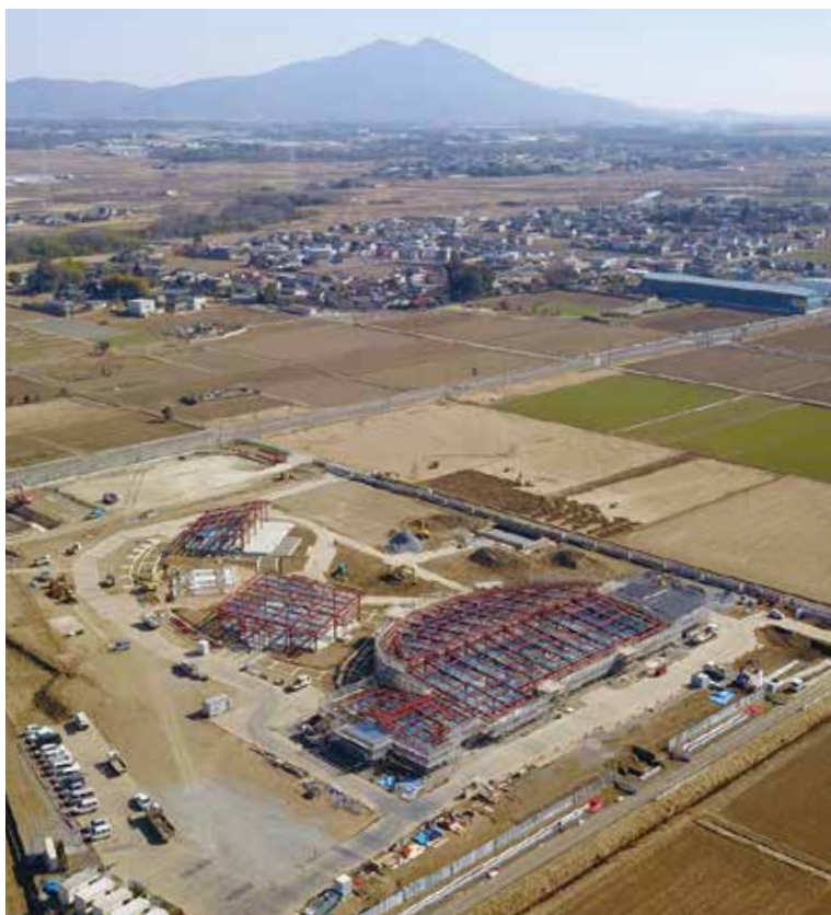
完成が待たれる、道の駅「グランテラス筑西」の現在の様子（2月18日撮影）。今年の筑西市の目玉であり、にぎわい創出の拠点として私たちに楽しさを届けてくれるものになってくれることを願います。
