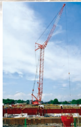
▲高さ45メートル以上の大型クレーン
