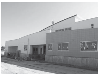
建設中の下館学校給食センター
