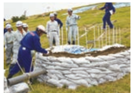
▲堤防から吹き出した水のはけ口が広がるのを防ぐ「月の輪工法」
