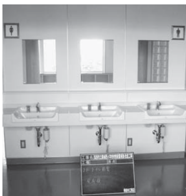
トイレ環境改善工事（実施後）
