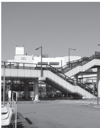
下館駅南北通路
