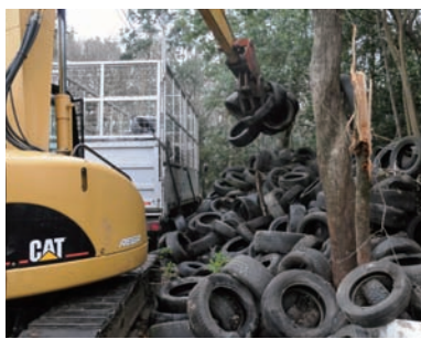
▲山積みの廃タイヤがきれいに撤去されました
