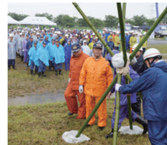
▲堤防の亀裂や崩れを防ぐ「五徳縫い」見事な仕上がりを確認しました。
