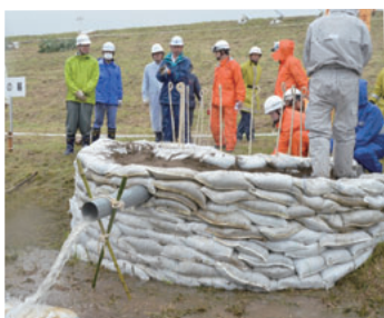
▲堤防から吹き出した水のはけ口が広がるのを防ぐ伝統的な工法「月の輪」
