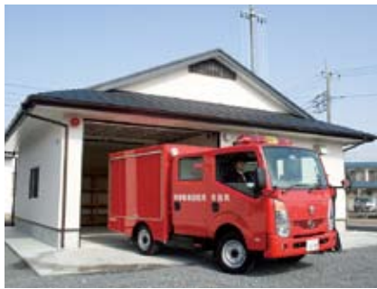
国から無償貸与された資機材搭載型車両の車庫と詰所が旧税務署跡地に完成。
