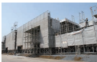
【建設が進む協和中学校～23年度】今年度には1期工事が完了し、生徒たちは新校舎に移る予定です。下は完成イメージ
