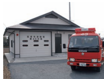
待望の第43分団消防車庫及び詰所が完成しました。広い敷地を有効活用した消防活動が期待されます。
