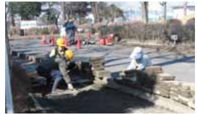
▲ボランティアで川島小学校の環境整備をする飯村造園土木のみなさん
