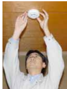
火災警報器は緊急通報システムと連動しています。
