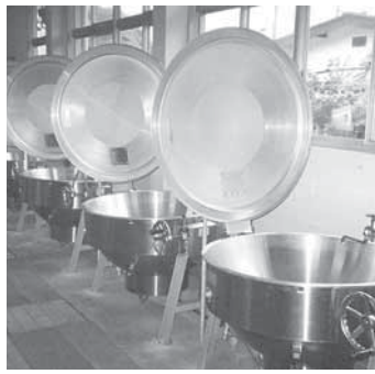
交換設置された調理機器
