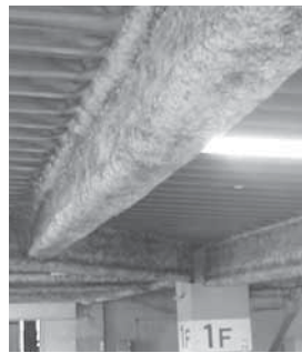
下館駅前立体駐車場天井にアスベストは使用されておりません
