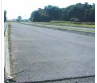
整備中の筑西・つくば線明野バイパス
