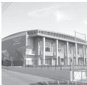
関城中学校体育館
