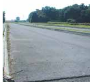
整備中の筑西・つくば線明野バイパス
