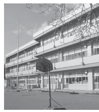
耐震補強が終了している上野小
