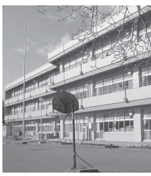
耐震補強が終了している上野小
