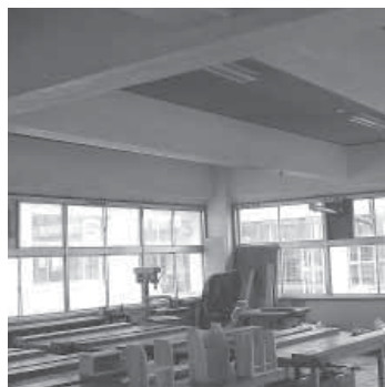
南中学校木工室
