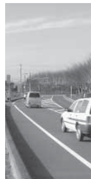
筑西幹線道路 (西方地内)
