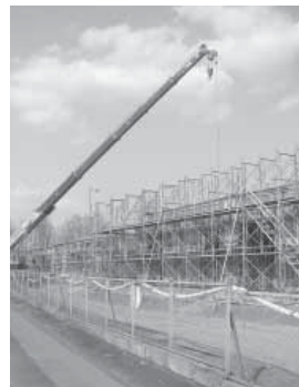
建設中の明野中学校
