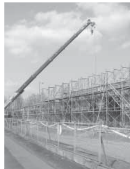
建設中の明野中学校
