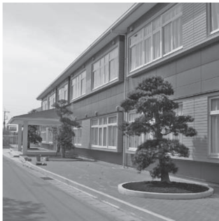
建設が進むつくば薬科大学
