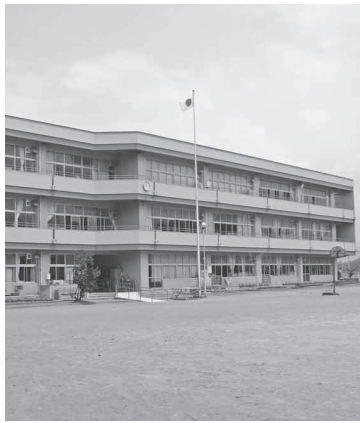
耐震補強が終了している上野小
