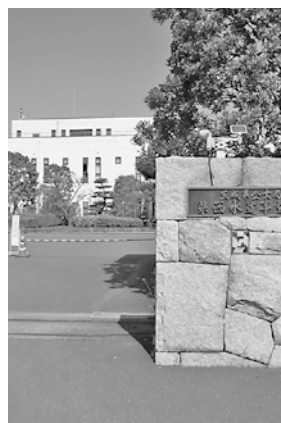
県西地域に水道水を供給する県西水道事務所
