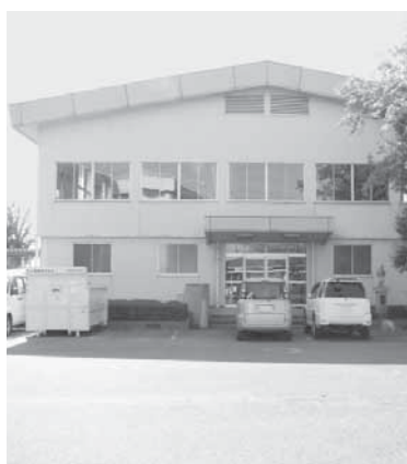
伊讃小学校体育館
