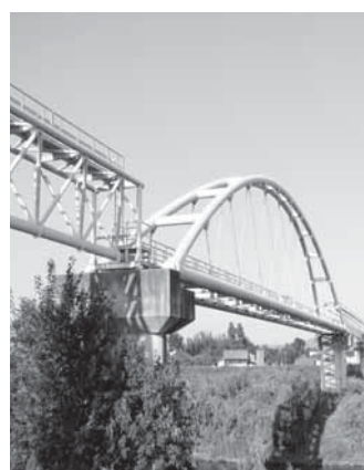
五行川水管橋
