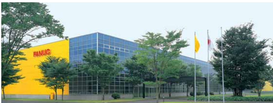
操業中の けやき 櫻の工場外観（ あけほのすき 曙杉の工場は植栽を含め現在建設中）
