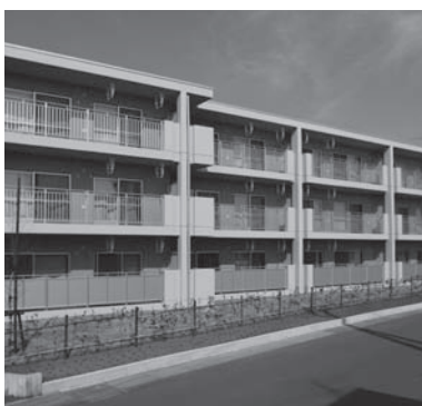
沖田地区市営住宅はすでに2棟が供用を開始。今年度に最後の1棟が完成する予定です。
