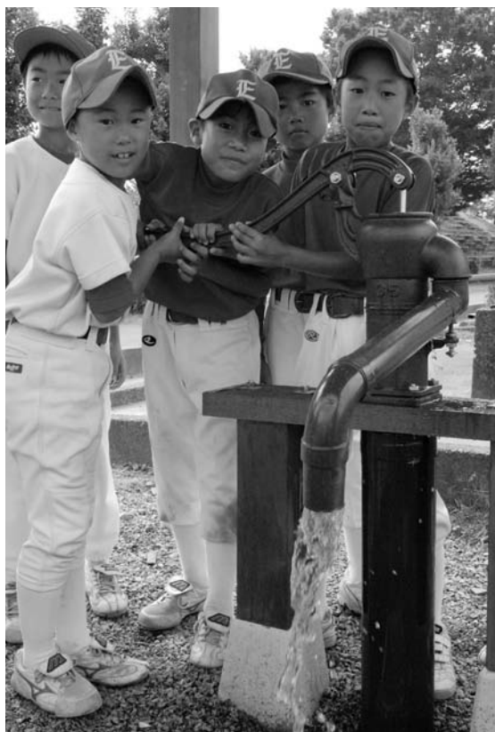
【簡易井戸】手動式のポンプを設置しました。
