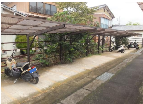
新治駅駐輪場（自動二輪車及び原動機付自転車）
